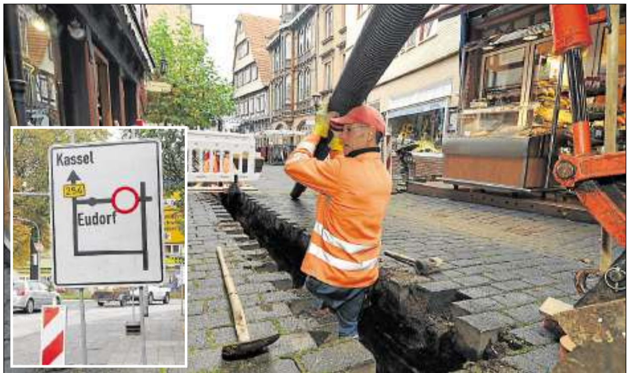
Bauarbeiten in und um Alsfeld: in der Obergasse, wo die Ovag Leitungen erneuert, wie auf den Ausfahrtstraßen.
